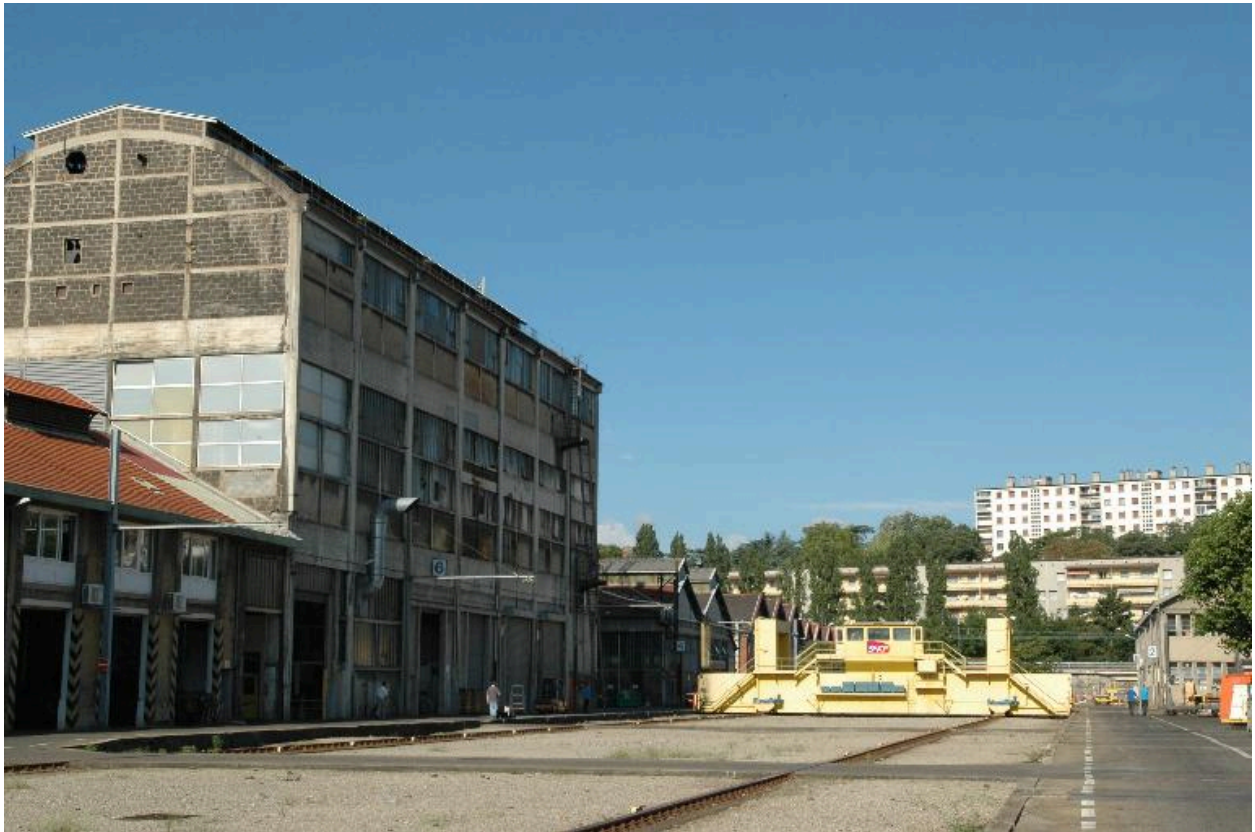
Vue extérieure de double halles
