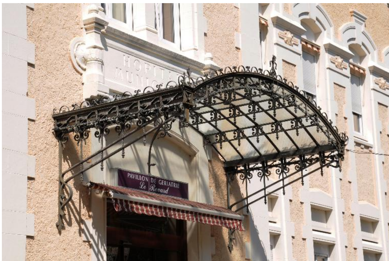
Façade principale, marquise de l'ancienne porte d'entrée
