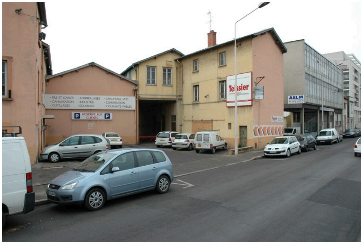
Vue d'ensemble nord-est
