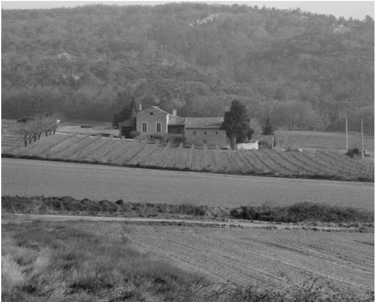
Les Planes (ZC 29). Ferme, vue dans son site.
