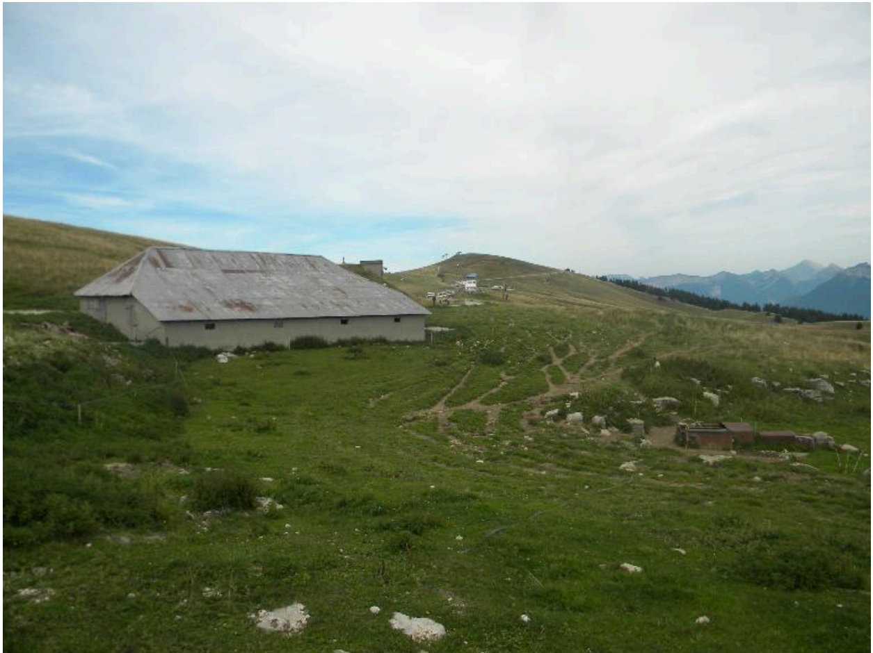
Vue d'ensemble depuis le sud de l'ancienne porcherie.
