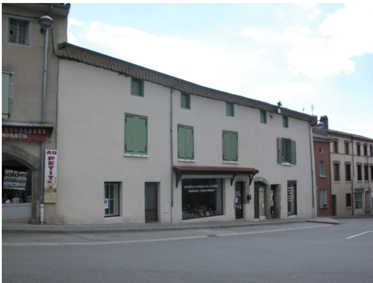
Îlot 9. Carnot (place) 28, 30. Vue générale de la façade sur la place.
