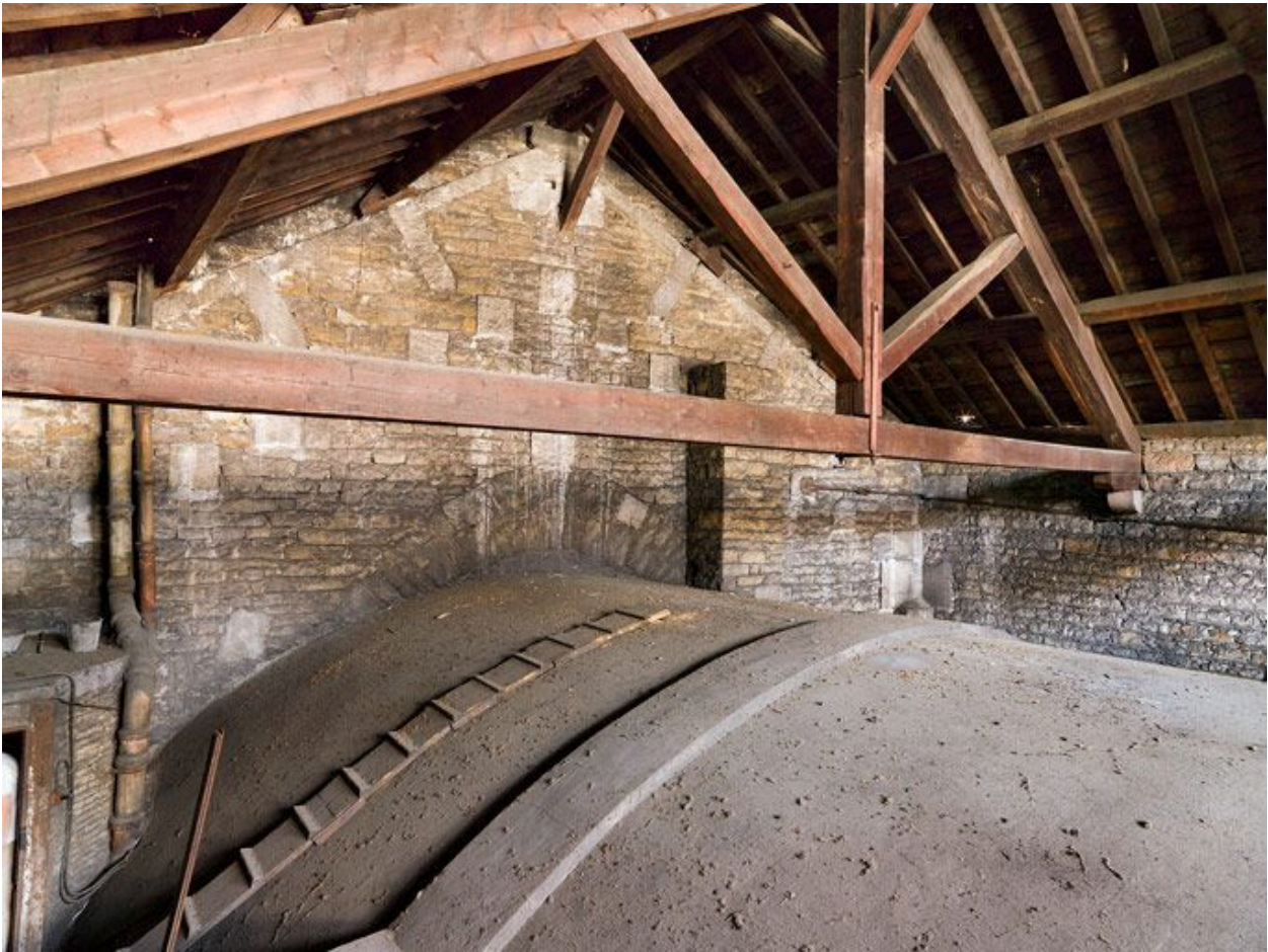
Combles et voûtes : mur côté quai Augagneur (ouest).
