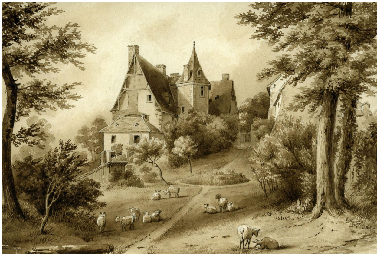
Vue est avant travaux
