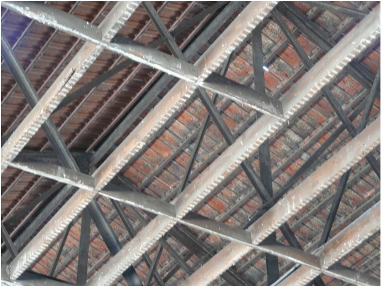
Détail structure métallique
