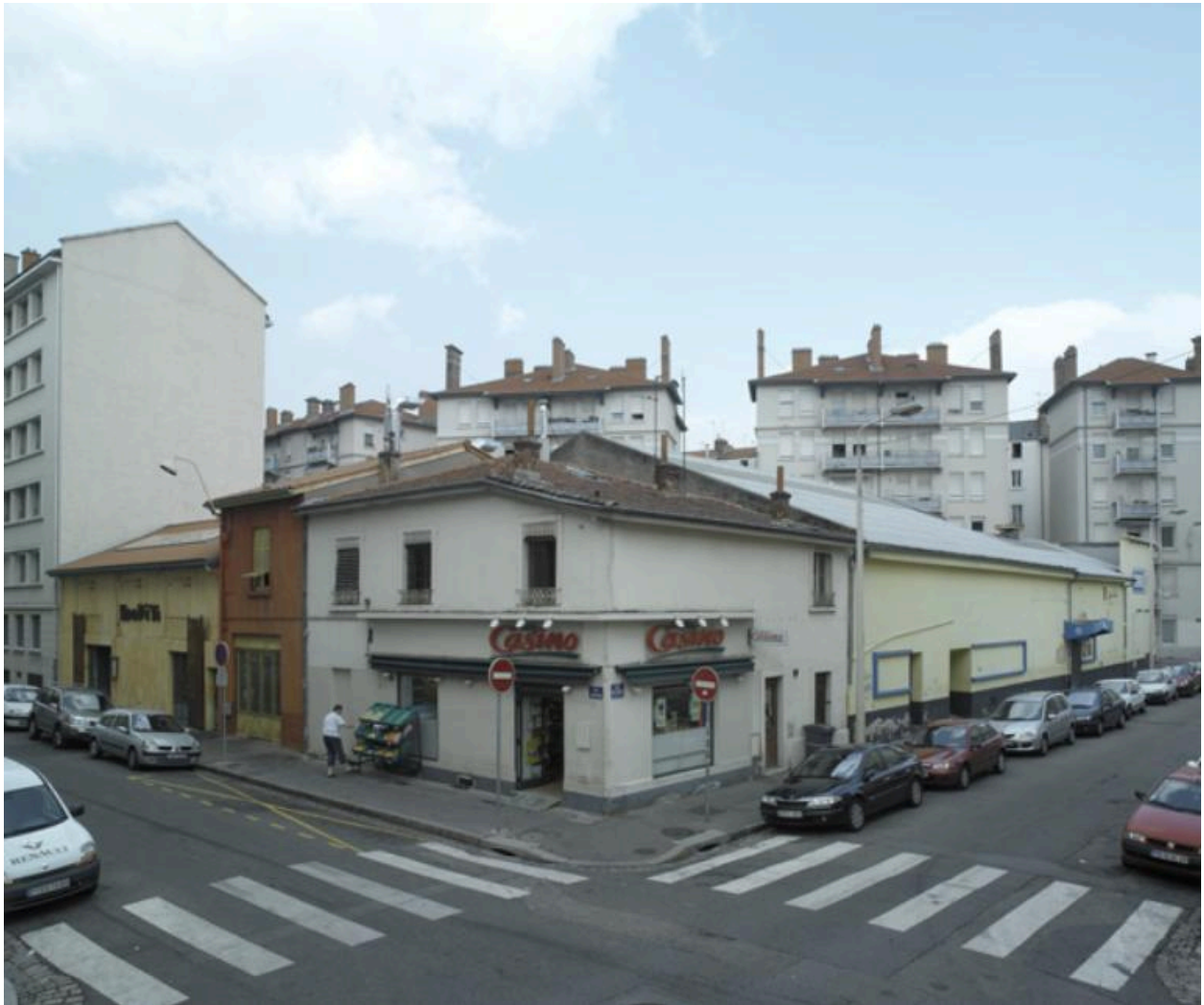
Vue d'ensemble sud
