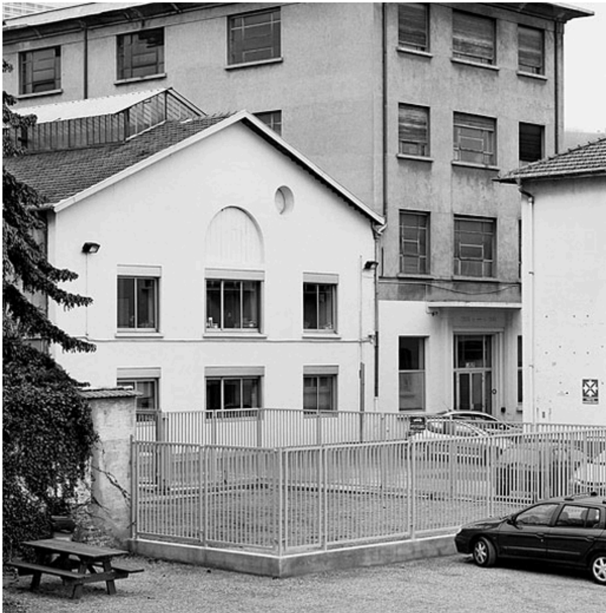
Détail lanterneau et atelier des années 1930
