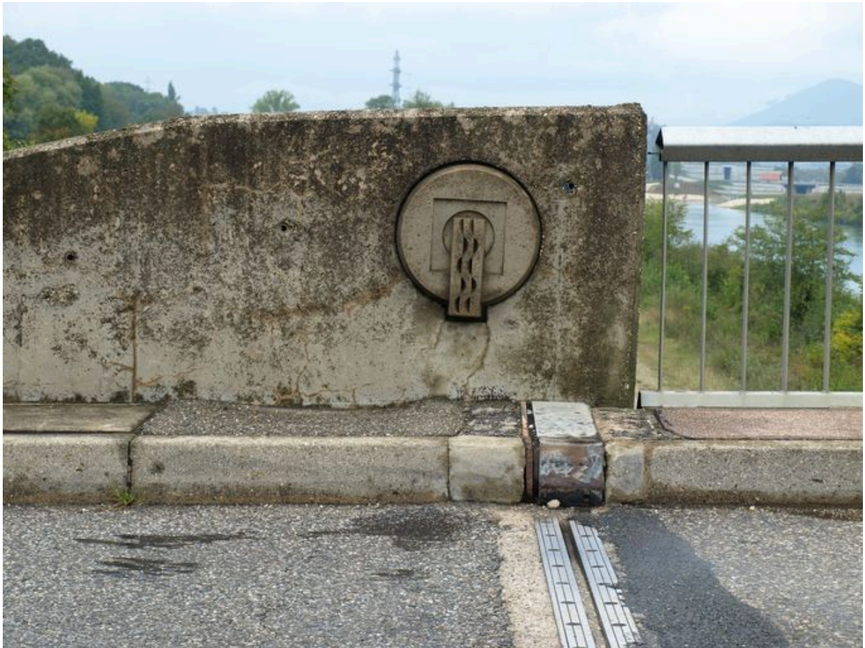
Motif circulaire moulé en béton à l'entrée du pont
