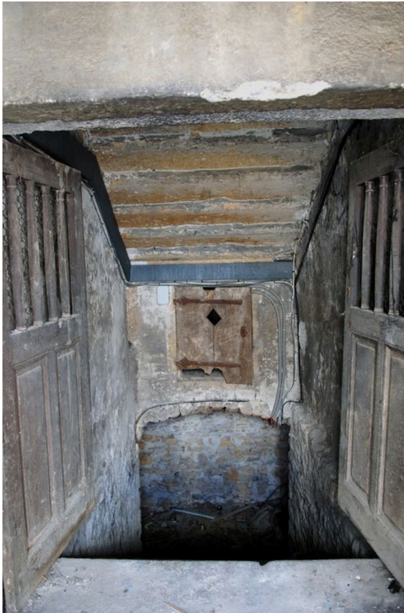
Porte d'accès aux caves, depuis la Belle Cour
