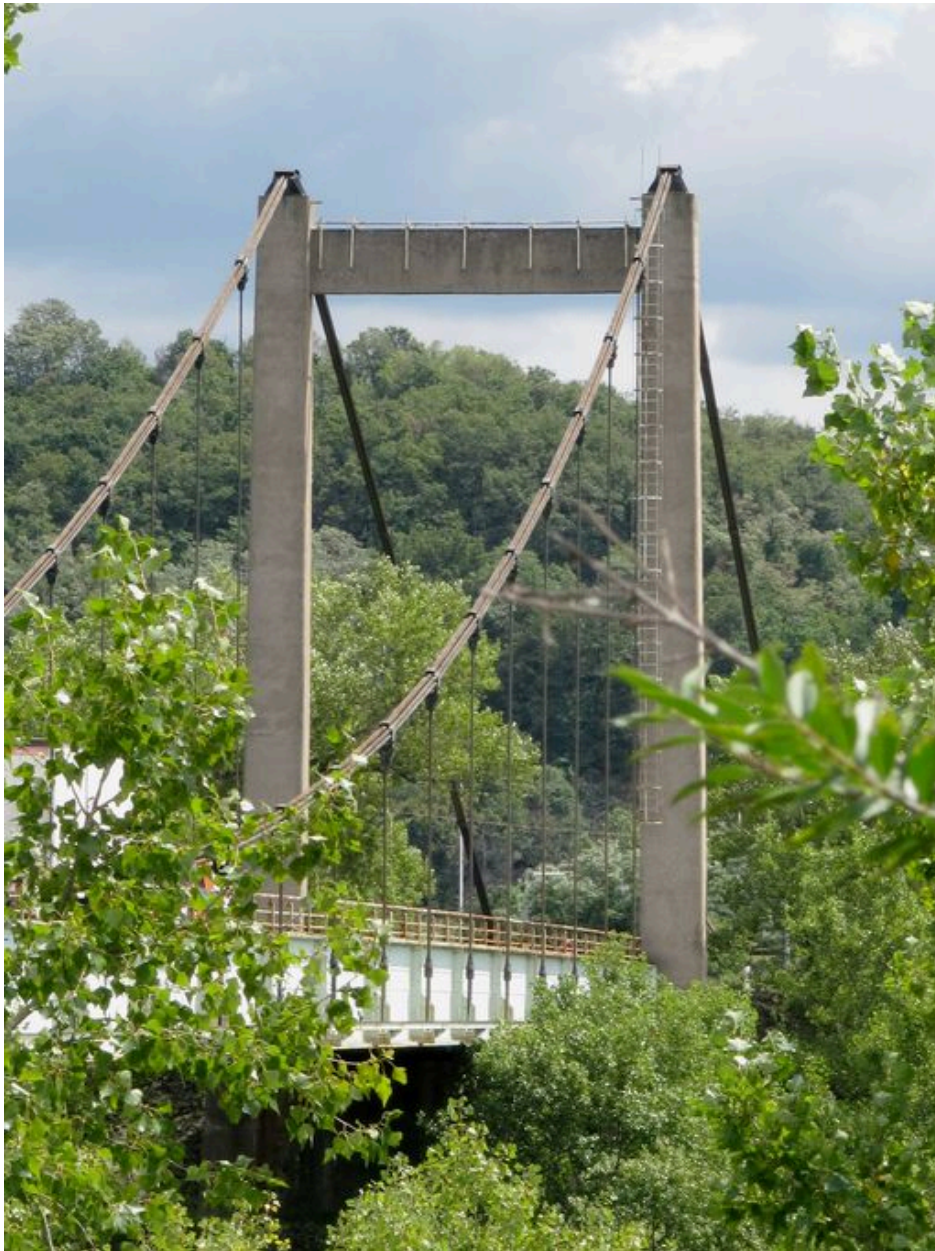
Pylône de la rive gauche (depuis la rive droite, face aval)
