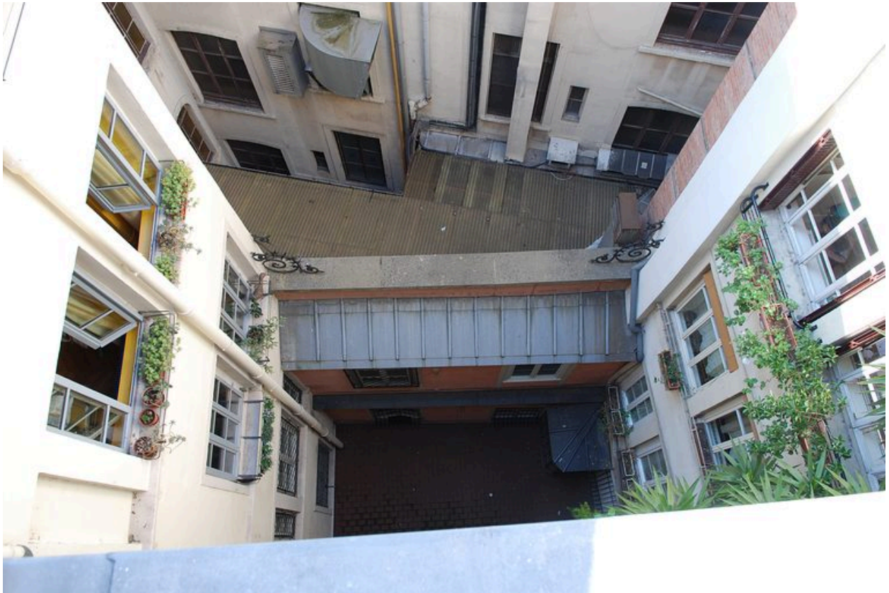
Vue de la cour principale en plongée
