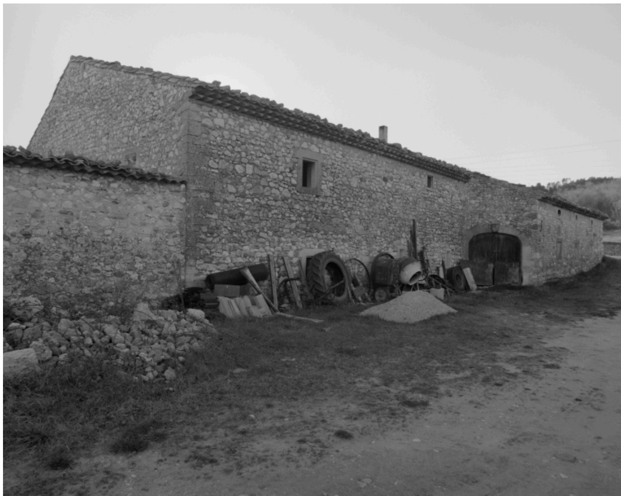
Vue générale de l'élévation postérieure.
