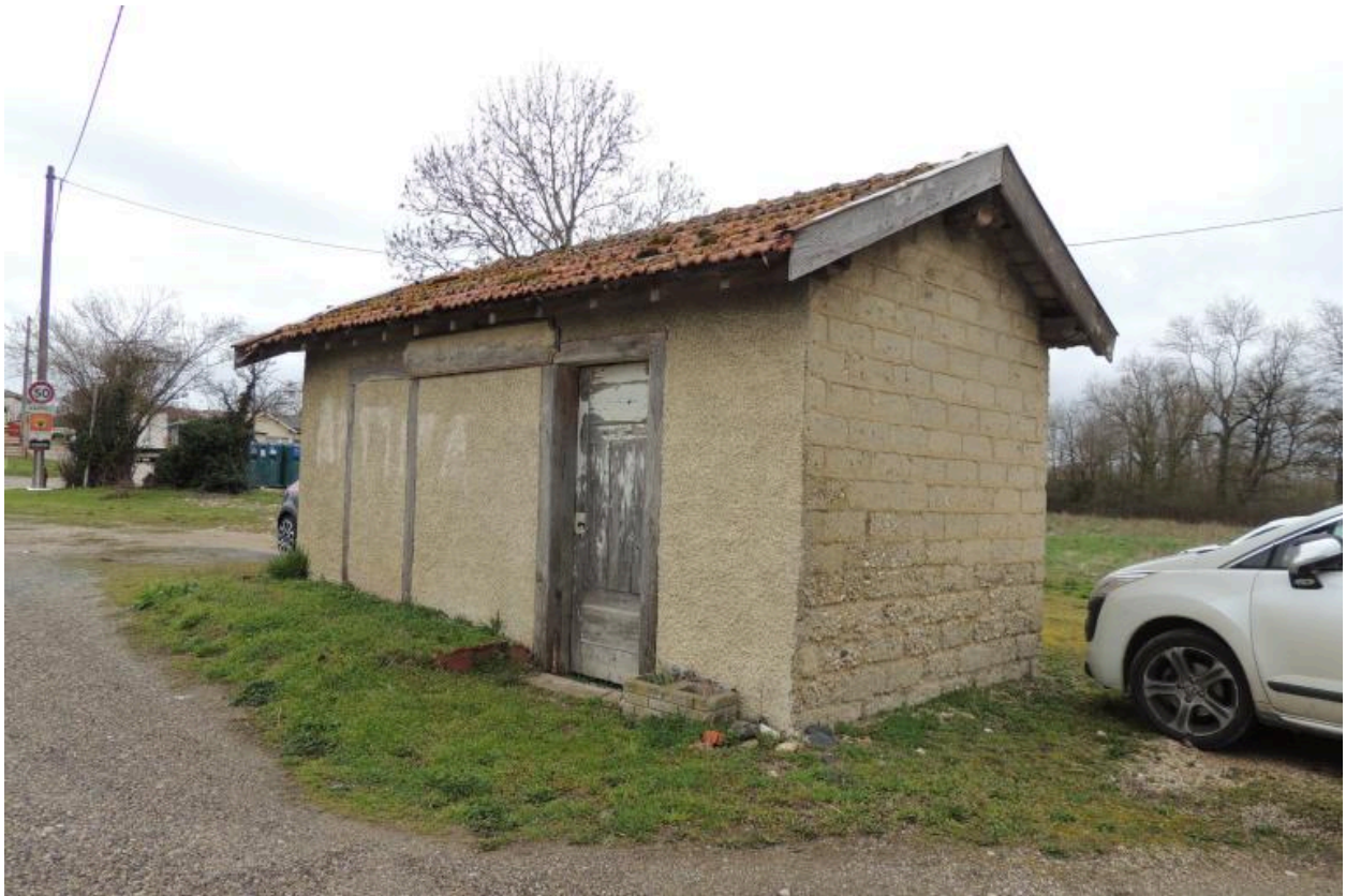
Vue d'ensemble, face sud.
