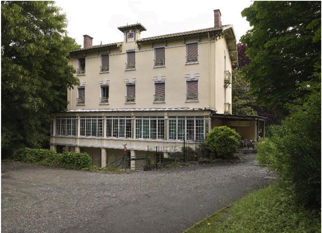
Vue d'ensemble, élévation sud
