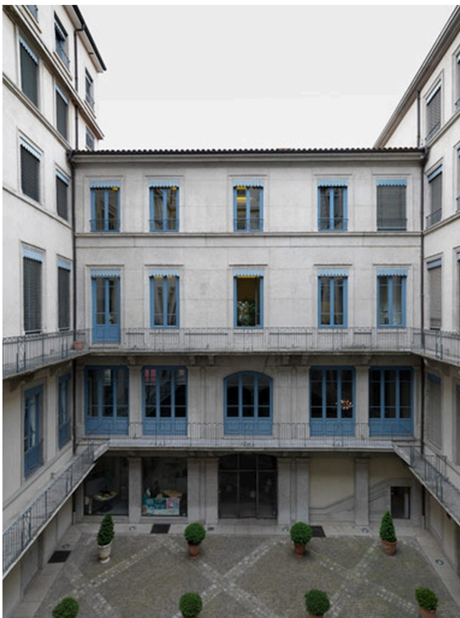
Vue de l'élévation sud de la cour
