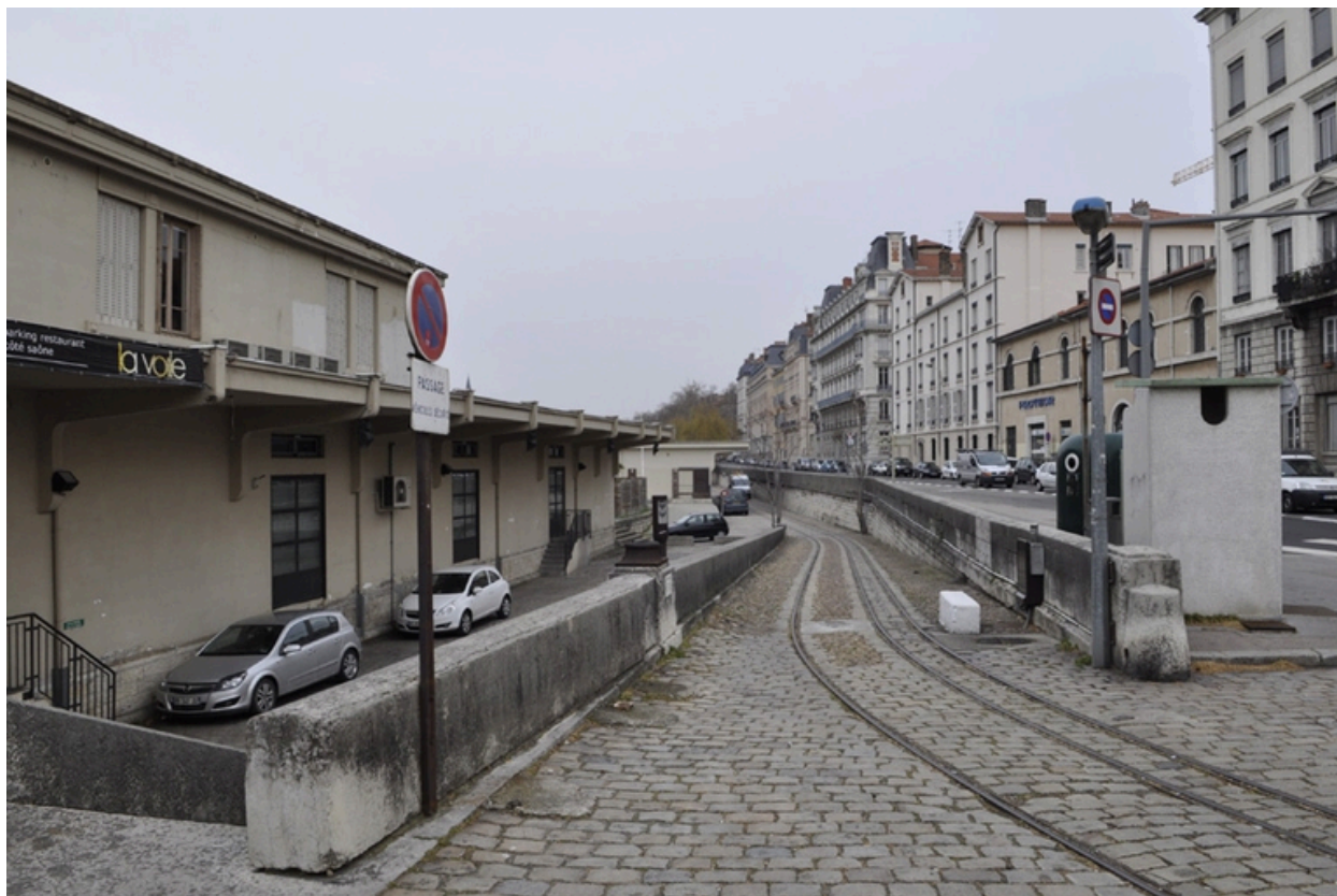
Rampe nord pavée et ferrée
