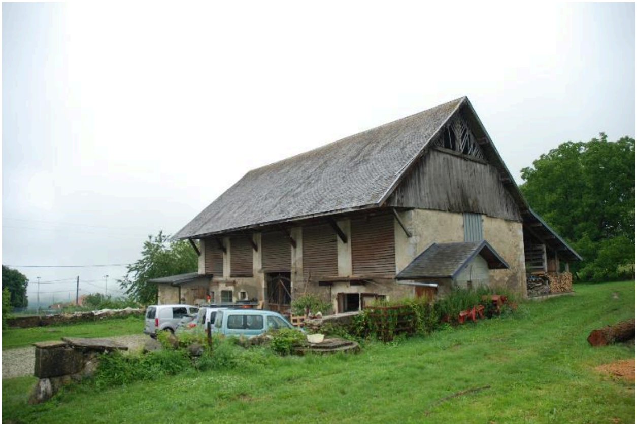
Vue d'ensemble de la grange-étable.
