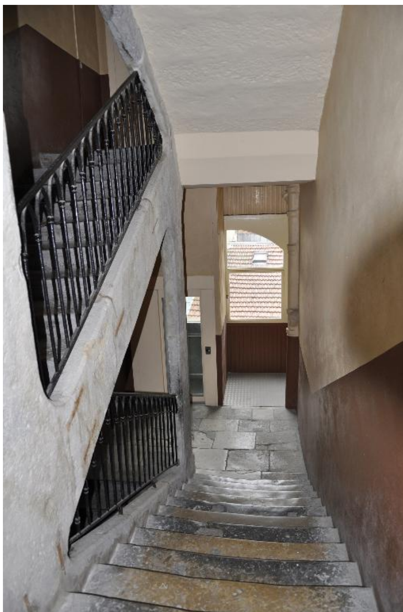
Mur noyau ajouré de l'escalier du n° 10 rue Dumenge
