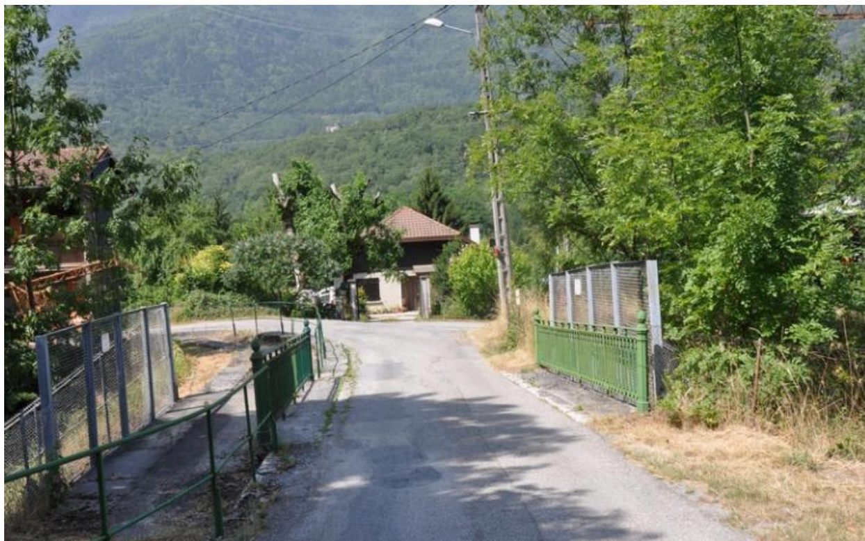
Vue de l'ancien moulin-scierie Garzend transformé en logement.
