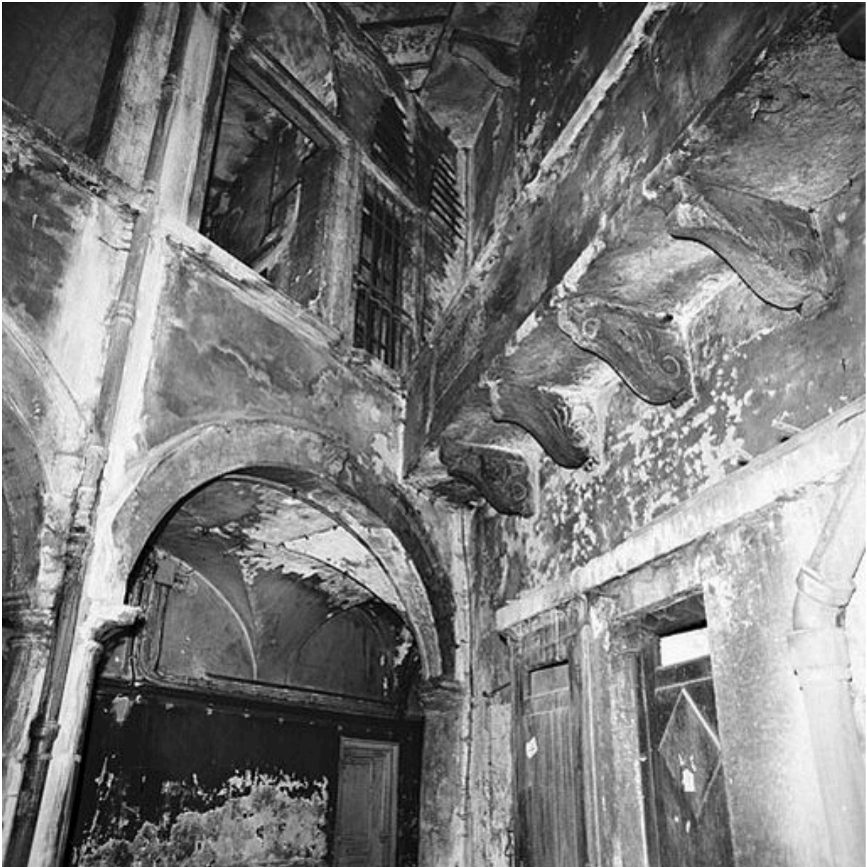
la cour : coursière en encorbellement sur consoles, 1976
