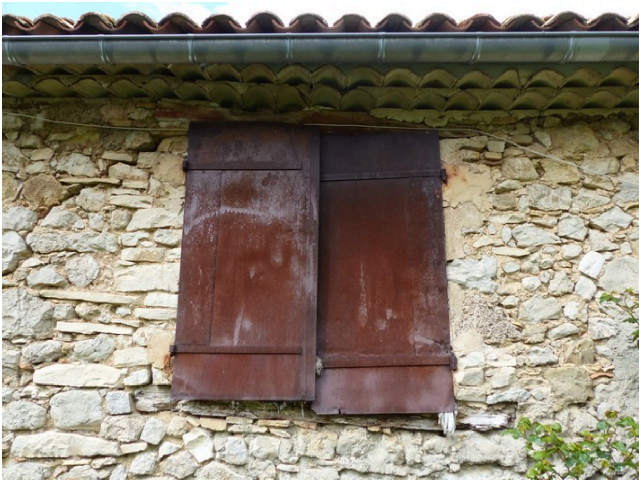
Bâtiment du logis. Elévation est, second niveau. Baie fenière.
