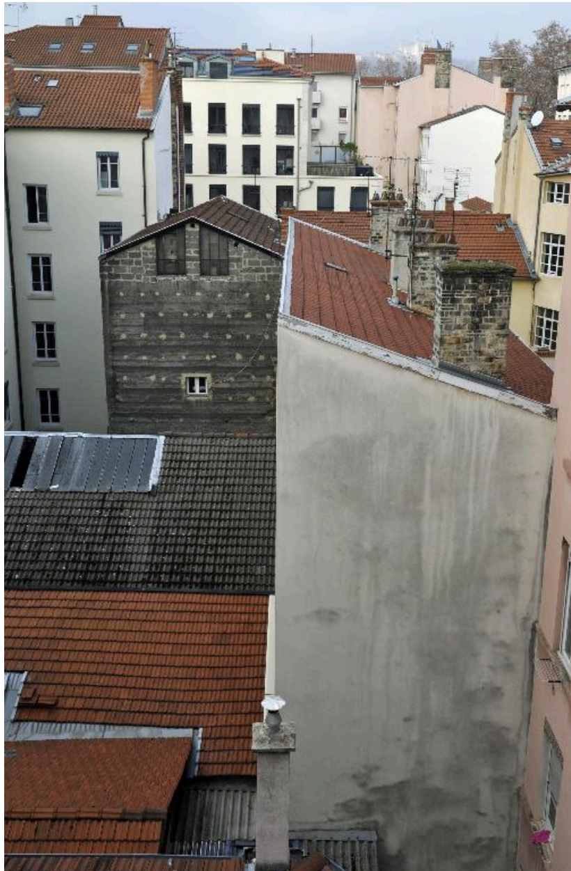
Immeuble sur cour : vue de la façade latérale aveugle, depuis l'est
