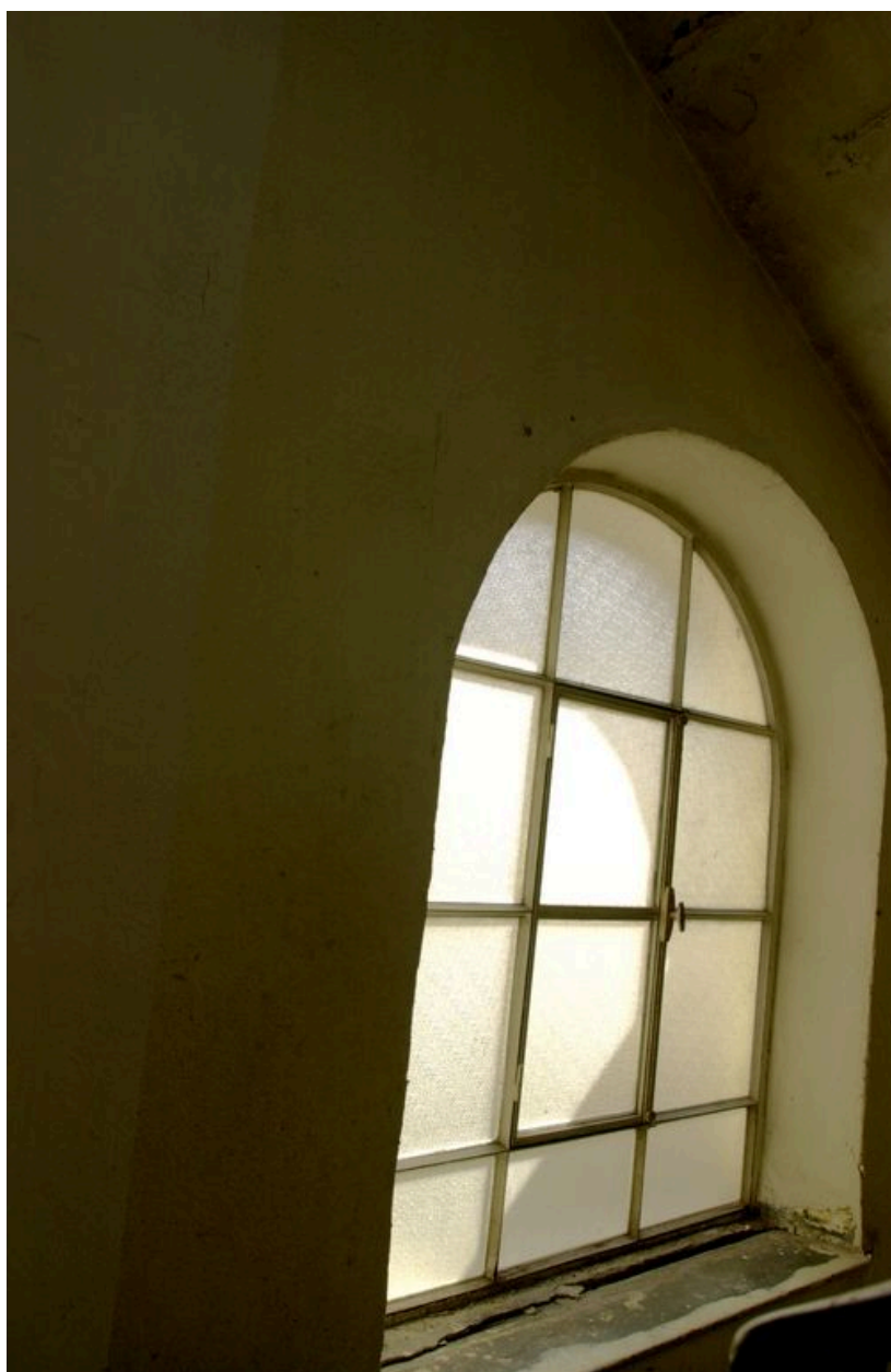
Baie éclairant l'escalier
