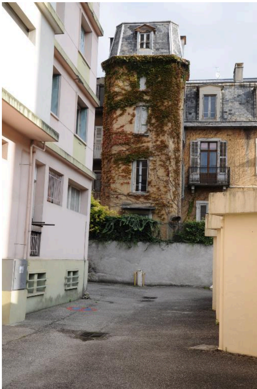
Tour rectangulaire à pans coupés, façade postérieure
