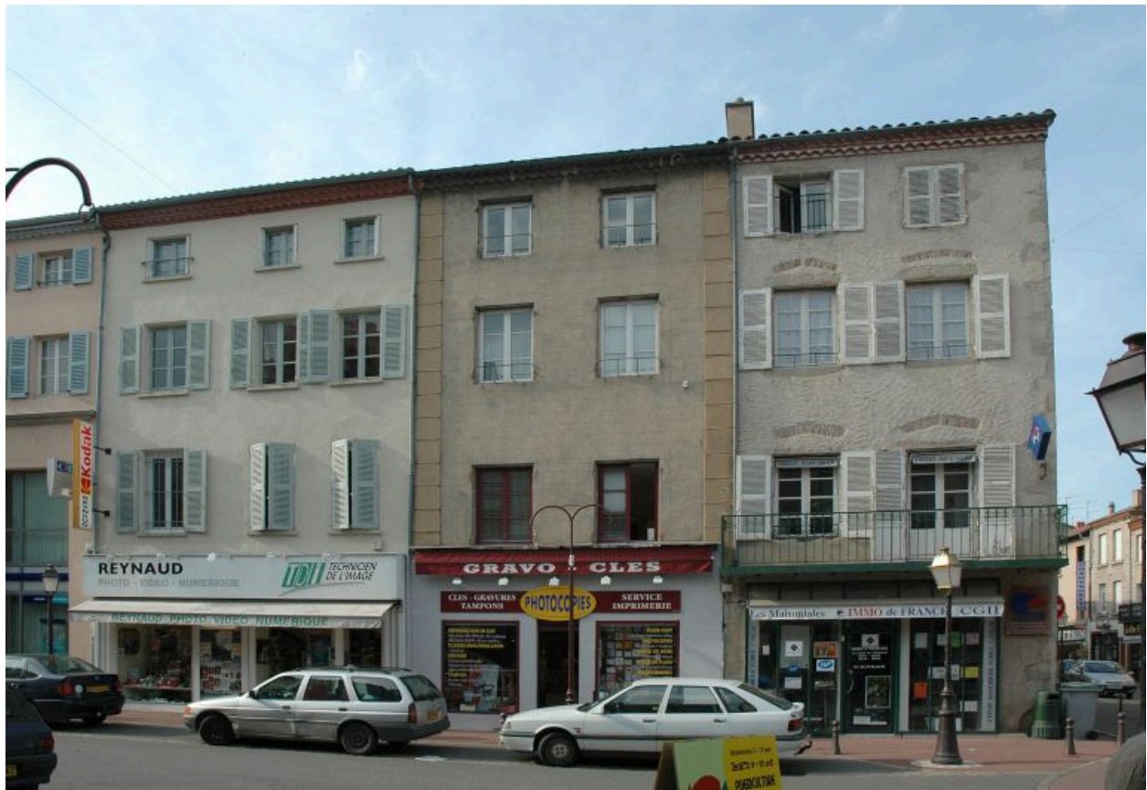
Vue générale, maison de droite.
