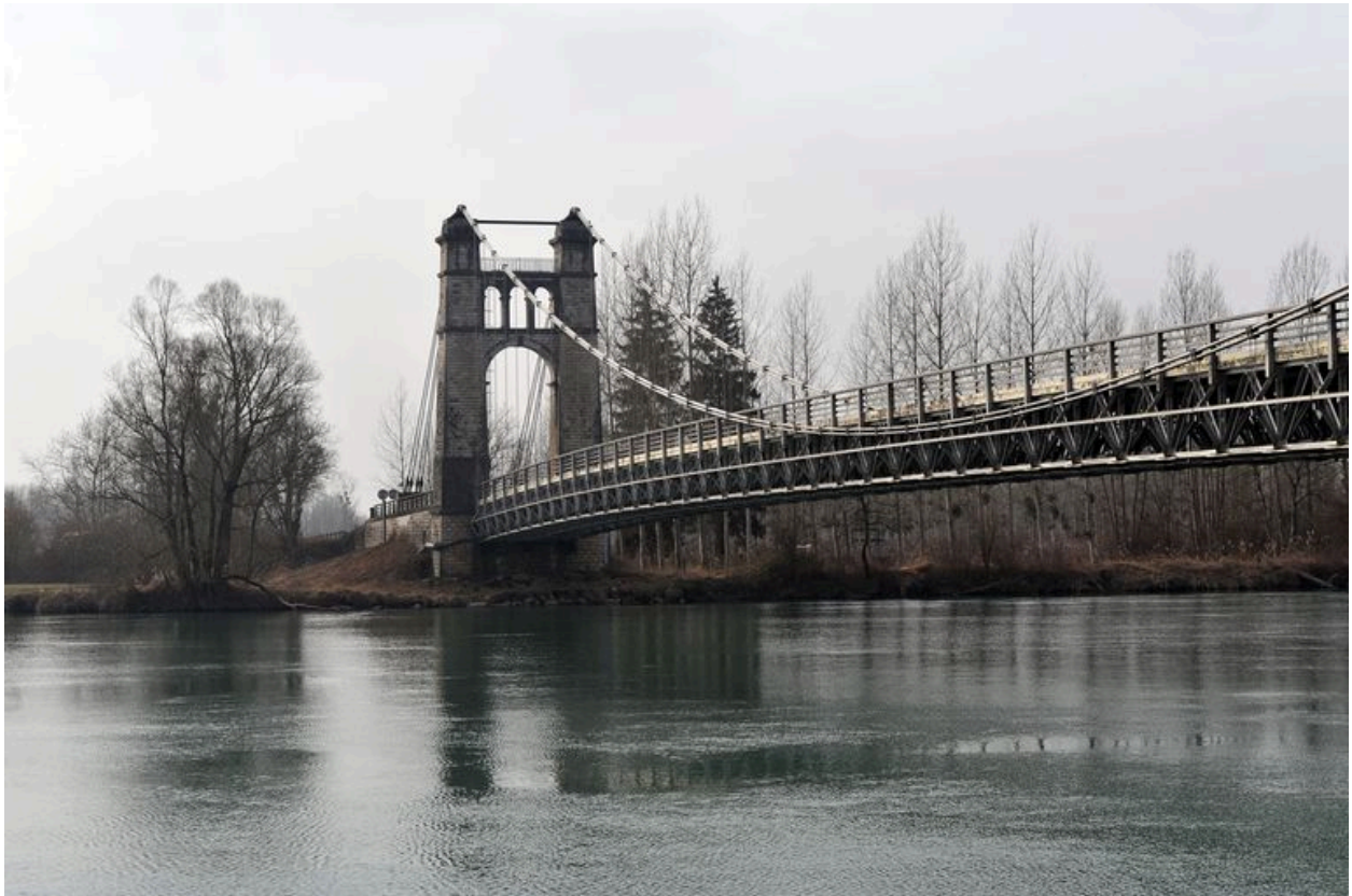
Vue partielle, face aval (depuis la rive gauche)
