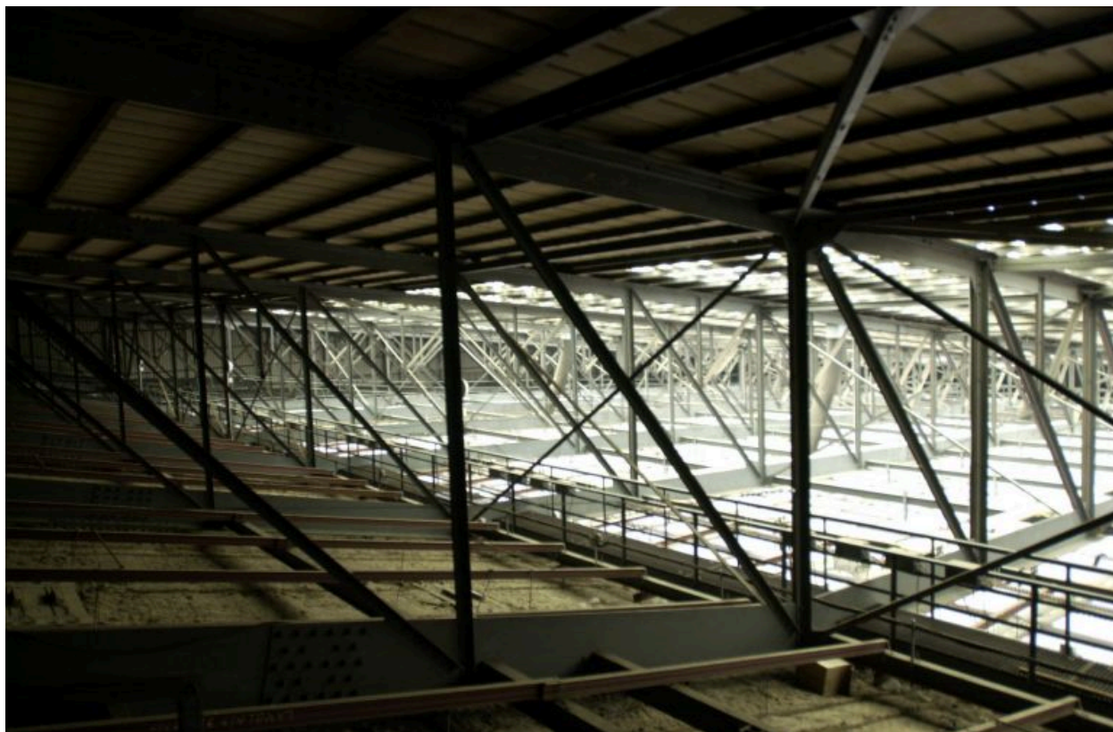
Fermes, entretoises et poutres de porte-à-faux : détail
