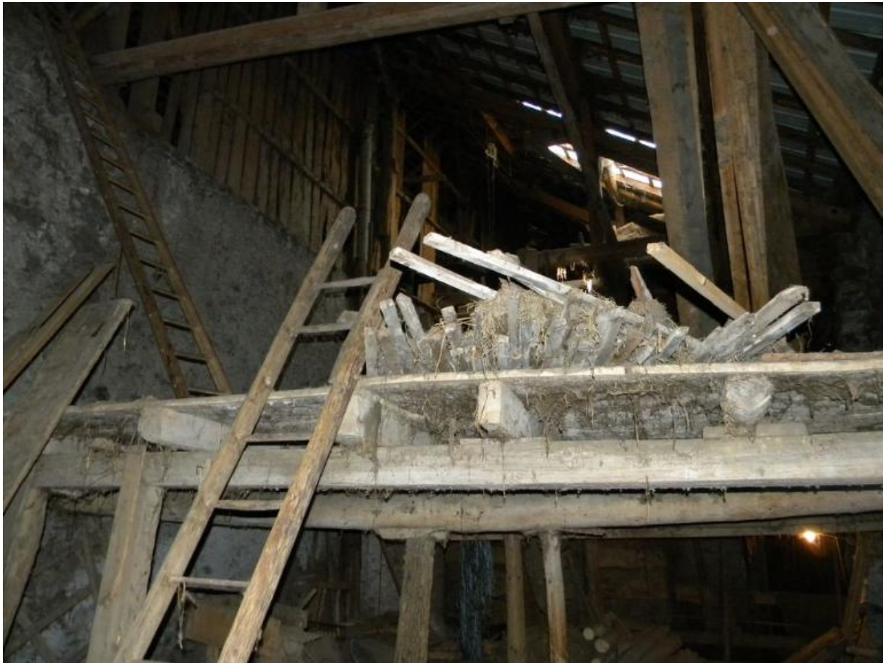
Vue d'un fenil accesssible par une échelle.
