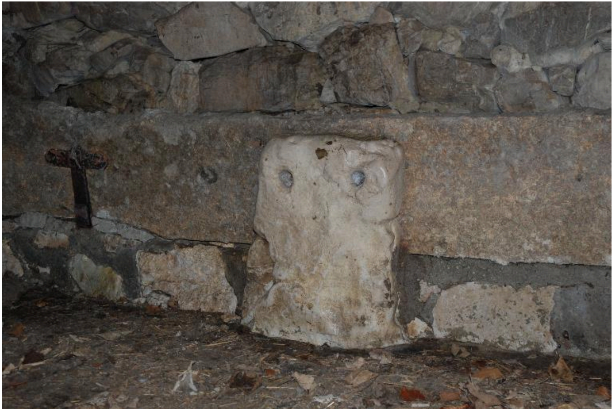
Vue intérieure de l'étable : détail de la pierre soutenant la mangeoire.
