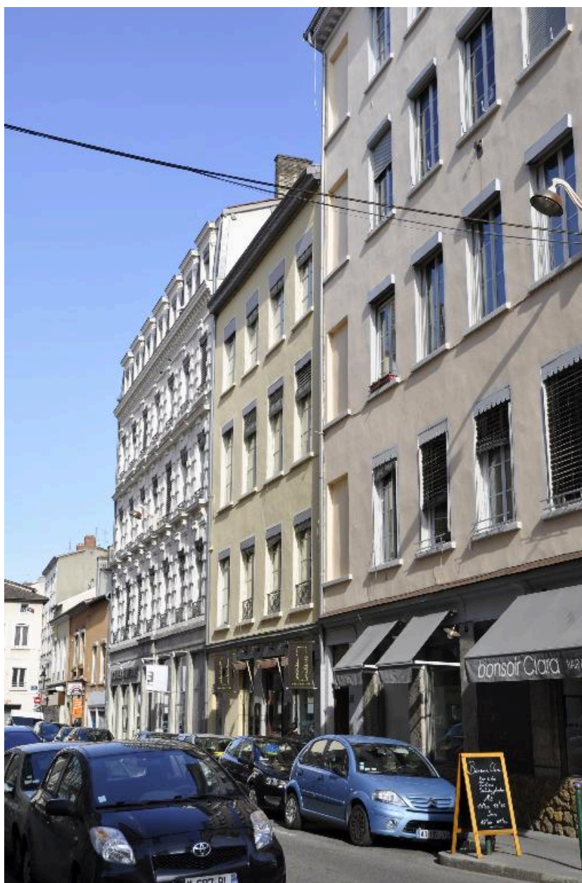
Vue d'ensemble sud est
