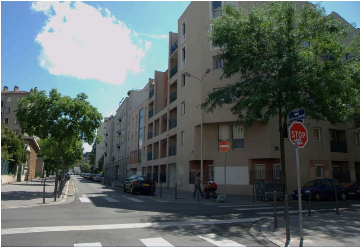
Elévation rue Docteur-Crestin depuis l'ouest
