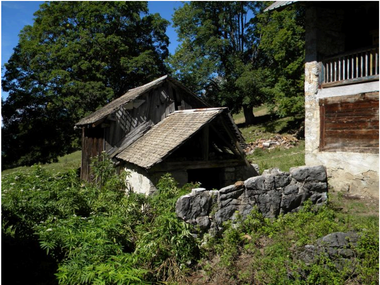
Vue d'une dépendance agricole devant un mur de pierres levées
