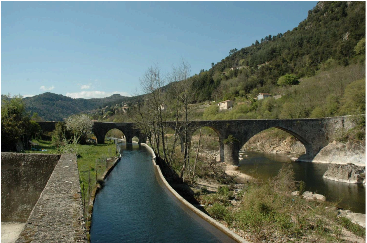
Canal et pont remarquable du Moulinon.
