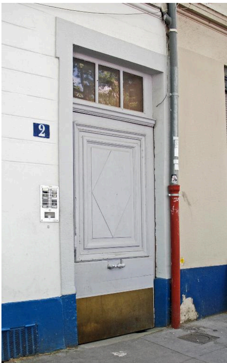
Détail de l'élévation sur quai : la porte piétonne
