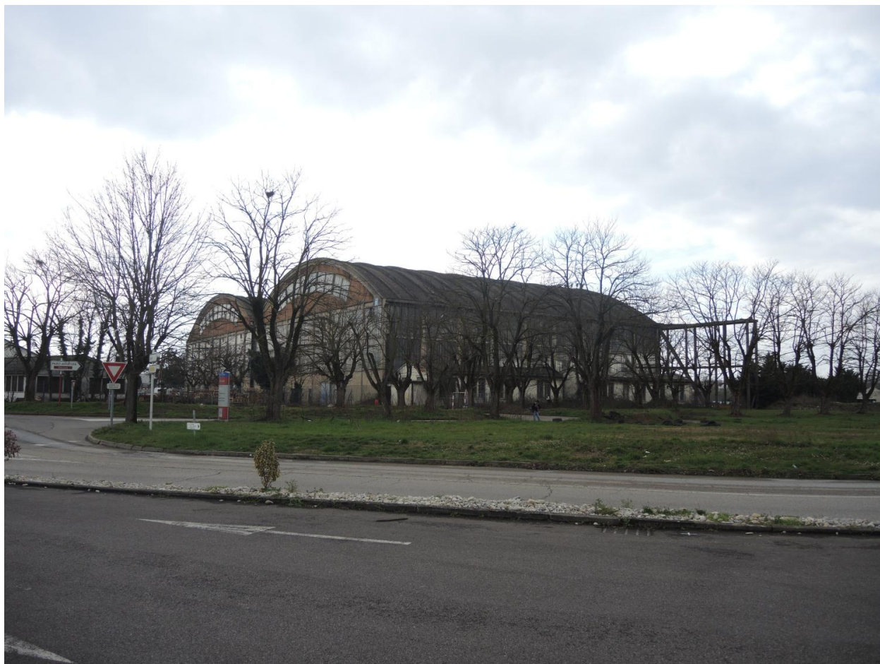
Hangar VI photo vue d'ensemble
