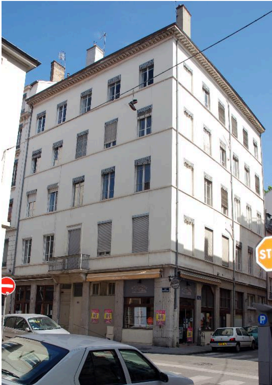
Vue d'ensemble depuis la rue Cavenne
