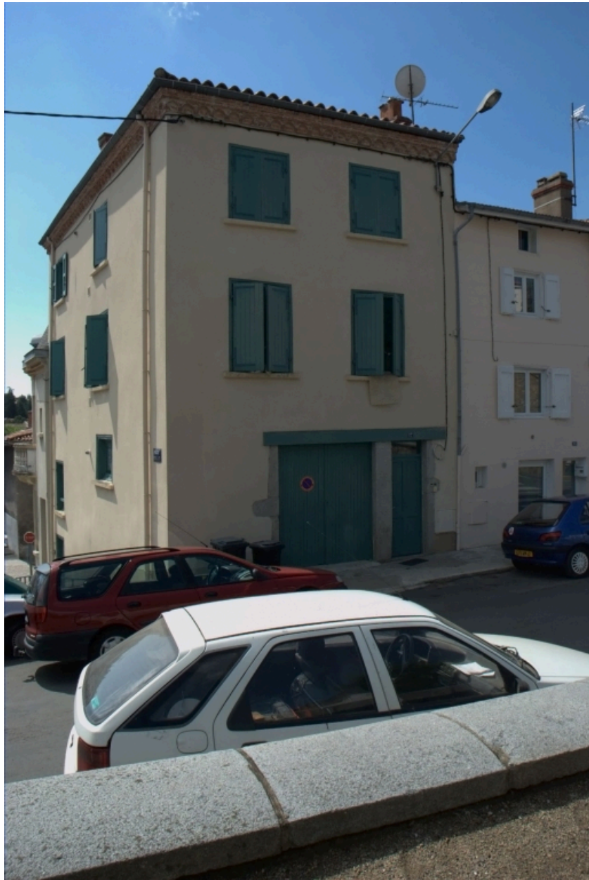
Îlot 3. Sordet (rue du) 17. Vue générale de la façade sur rue.
