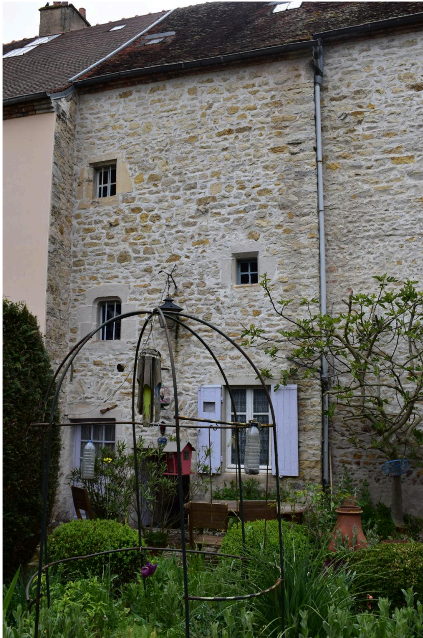
Vue de détail, partie sud, de la façade orientale de la maison.
