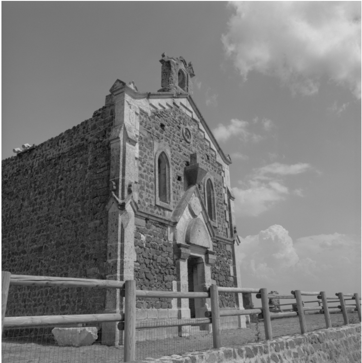
Vue extérieure générale de la façade principale de la chapelle, depuis le nord-ouest.
