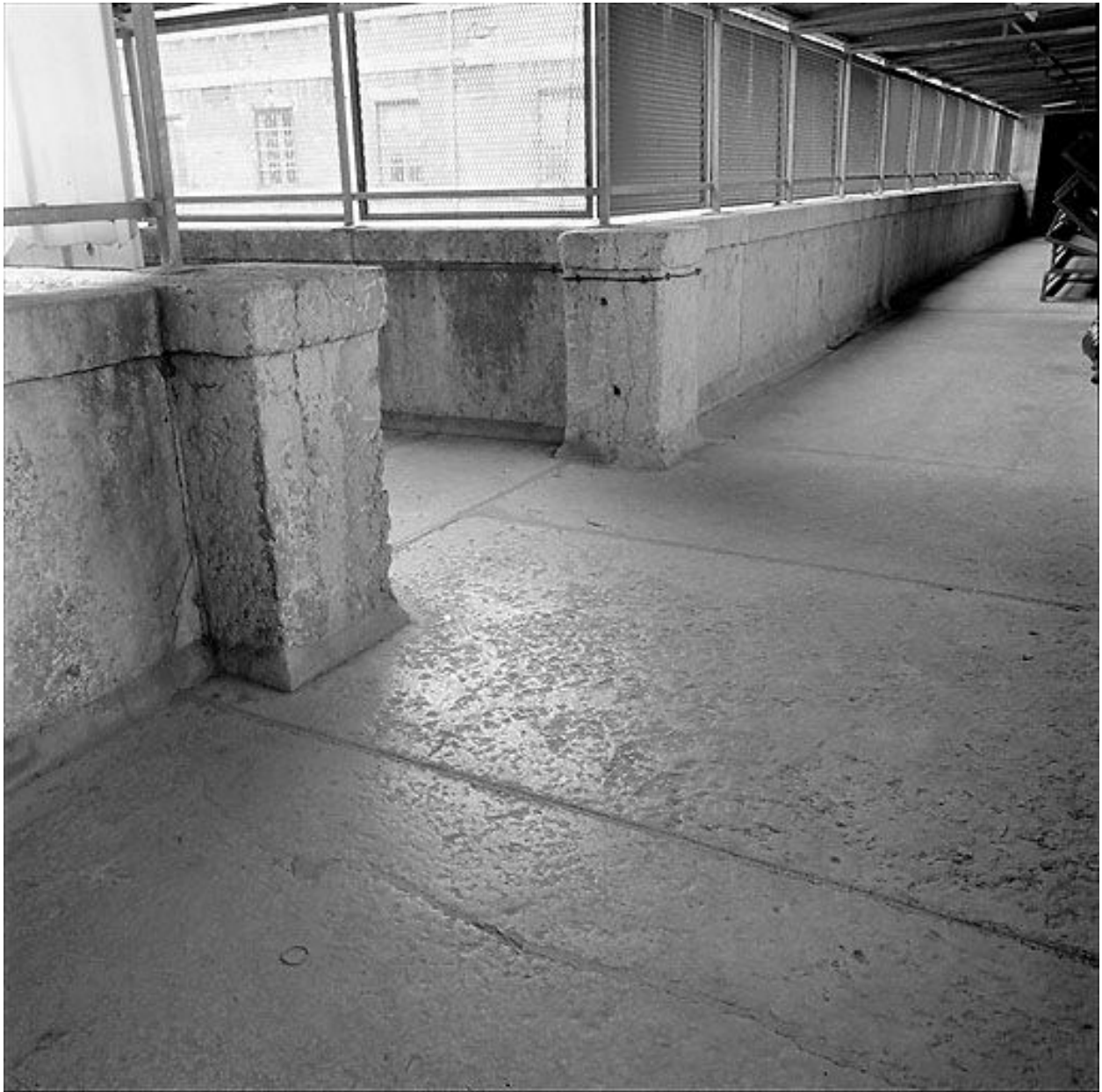
Premier étage, partie nord : la galerie
