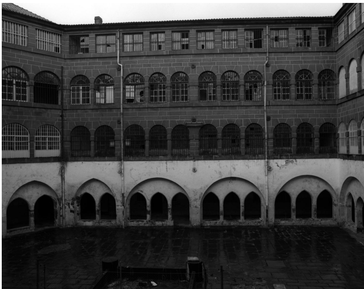
Cloître, élévation nord. Galerie du niveau de la cour du XIV e siècle et galeries-hautes correspondant à la surélévation du XIX e .
