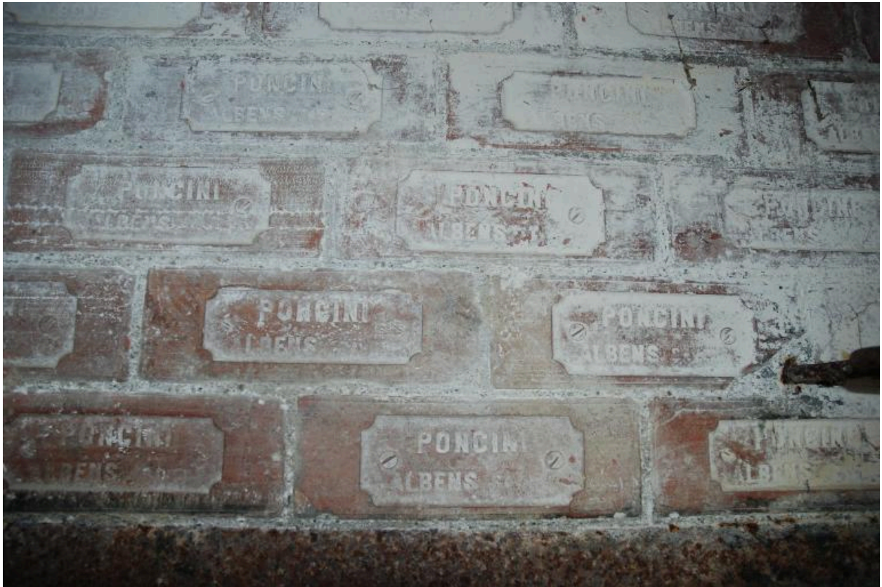
Vue intérieure du four à pain : détail des briques de la hotte (inscription : PONCINI / ALBENS SAVOIE).
