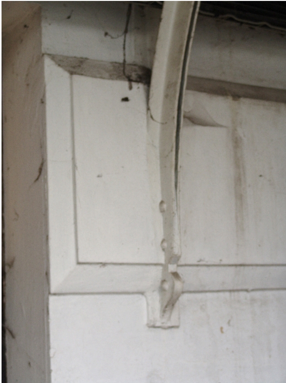
Galerie de circulation du 2e étage de soubassement, détail de la charpente métallique de l'escalier
