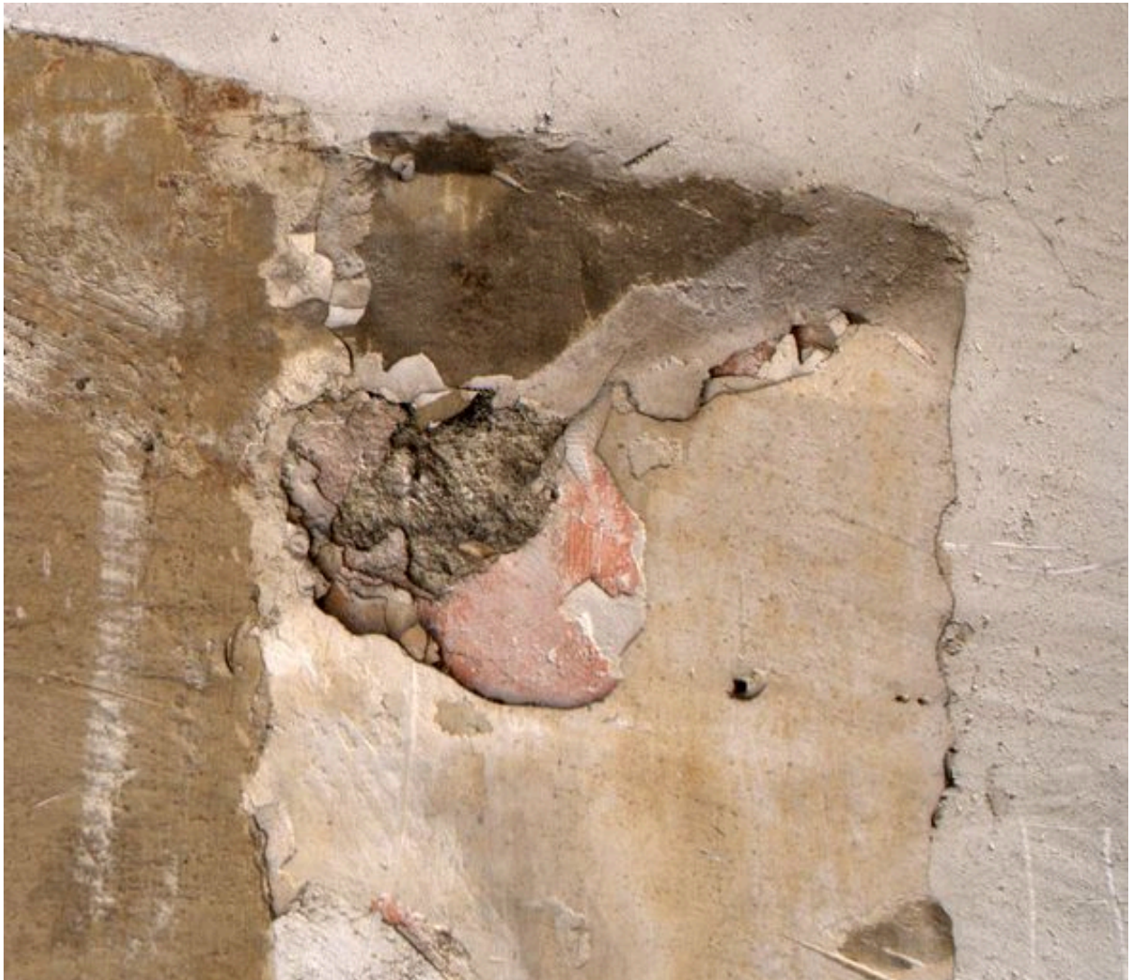
Cage d'escalier, détail des anciens enduits et badigeons
