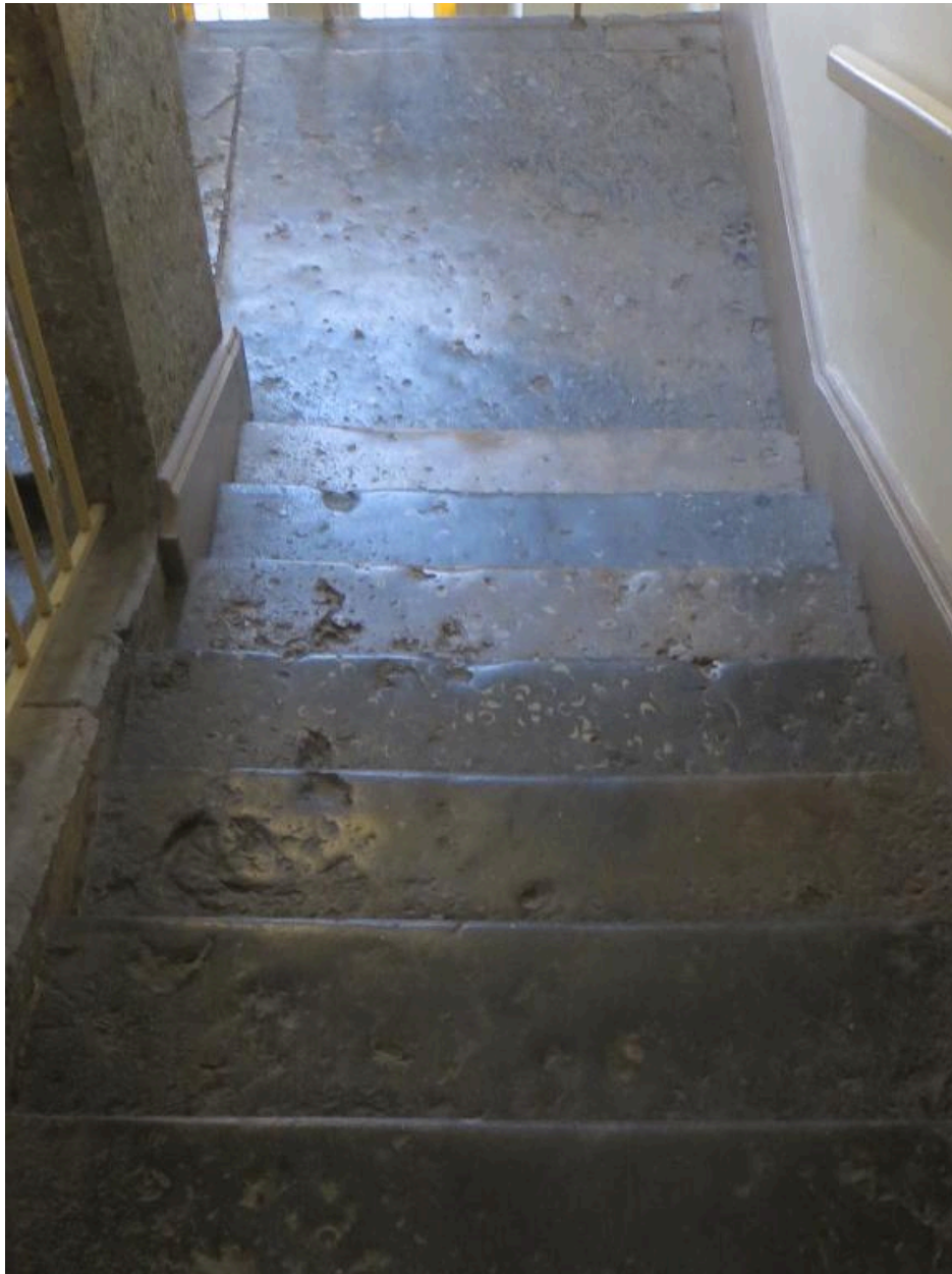
L'escalier : marches et vue partielle d'un repos
