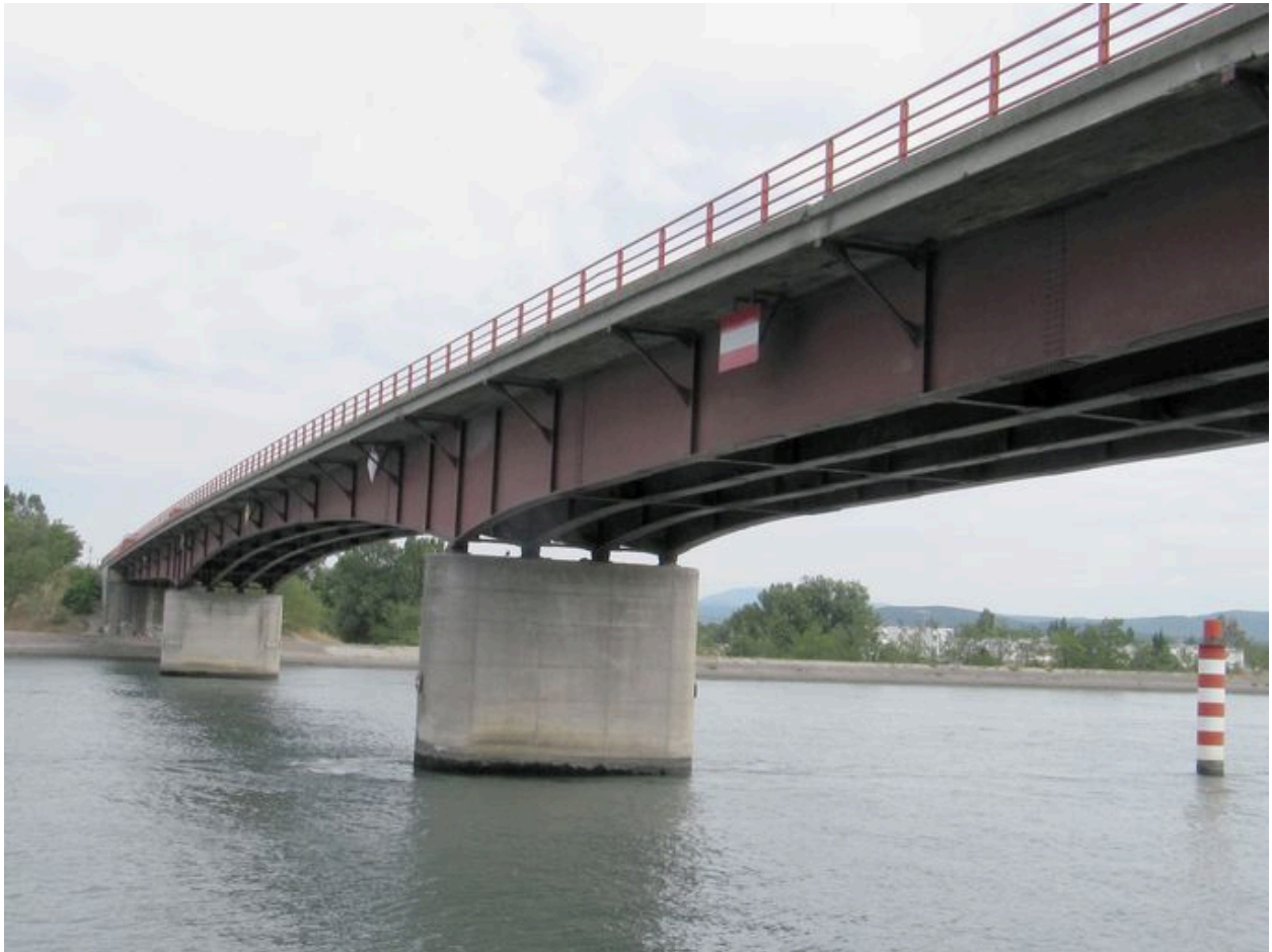
Vue partielle, de côté, face amont (depuis la rive droite)
